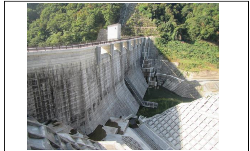
2 ダム上流面(左岸から)
