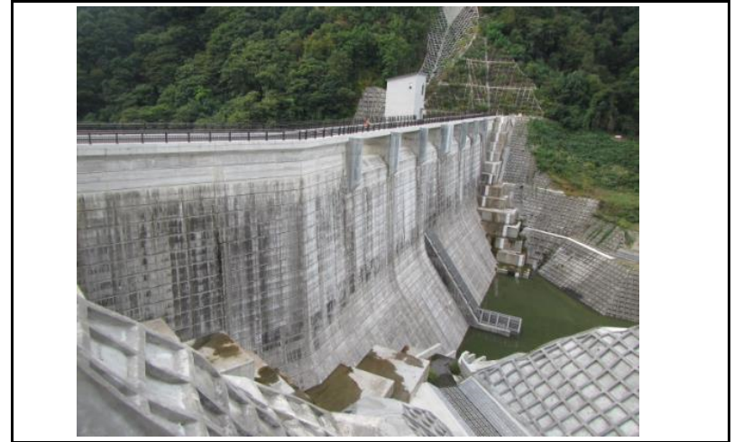
2 ダム上流面(左岸から)
