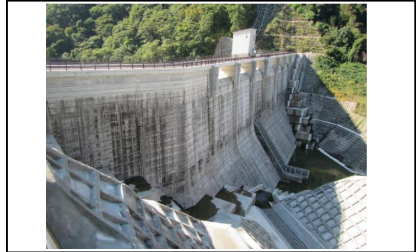
2 ダム上流面(左岸から)
