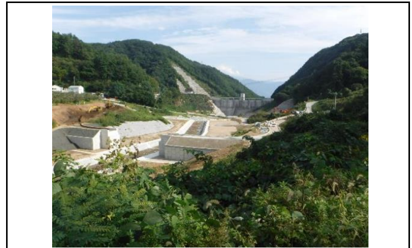
4 貯水池(上流からの全景)
