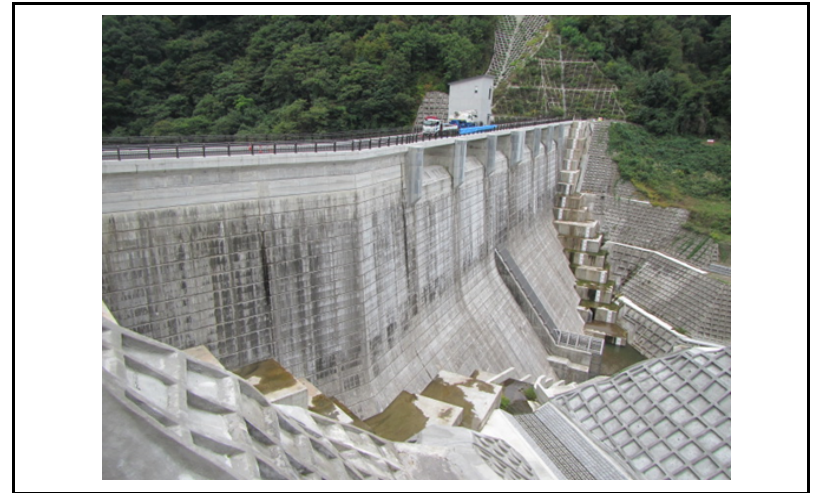
2 ダム上流面(左岸から)
