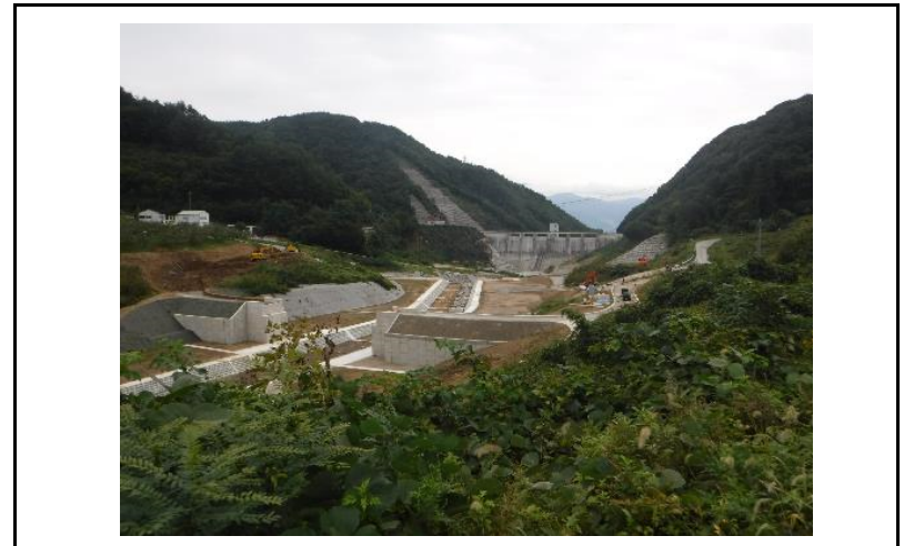
4 貯水池(上流からの全景)
